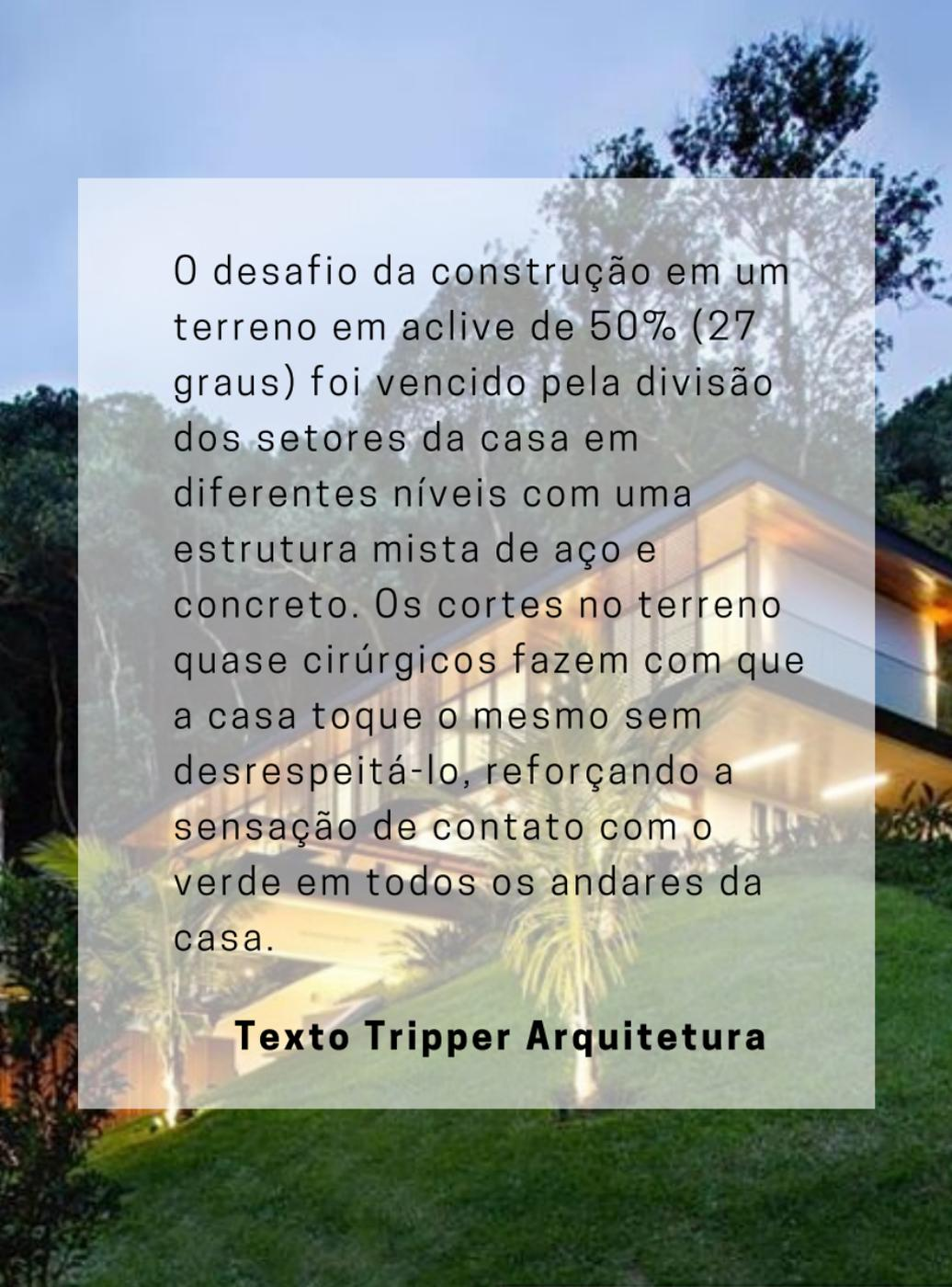
O desafio da construção em um terreno em aclive de 50% (27 graus) foi vencido pela divisão dos setores da casa em diferentes níveis com uma estrutura mista de aço e concreto. Os cortes no terreno quase cirúrgicos fazem com que a casa toque o mesmo sem desrespeitá-lo, reforçando a sensação de contato com o verde em todos os andares da casa.
